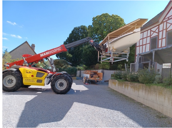
Präzisionsarbeit durch die Firma Ilg Foto: Urs Tobler
